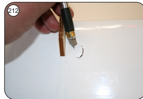
Durchführungsöffnungen an der Unterseite der Tragfläche freilegen.
